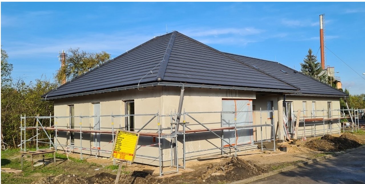
Nowo budowany obiekt administracyjno – biurowy.
