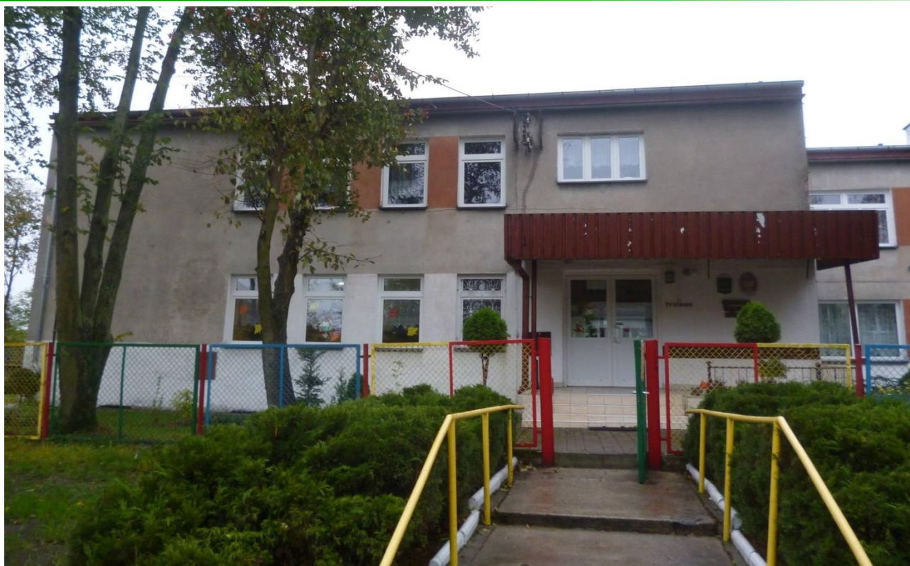
Foto: Przedszkole w Korszach przed termomodernizacją.
