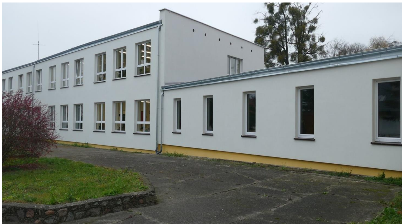
Foto: Szkoła Podstawowa w Korszach po termomodernizacji.
