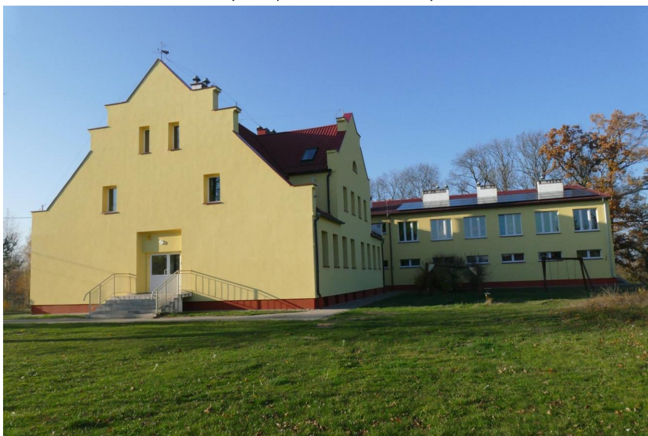
Foto: Szkoła Podstawowa w Łankiejmach po termomodernizacji.
