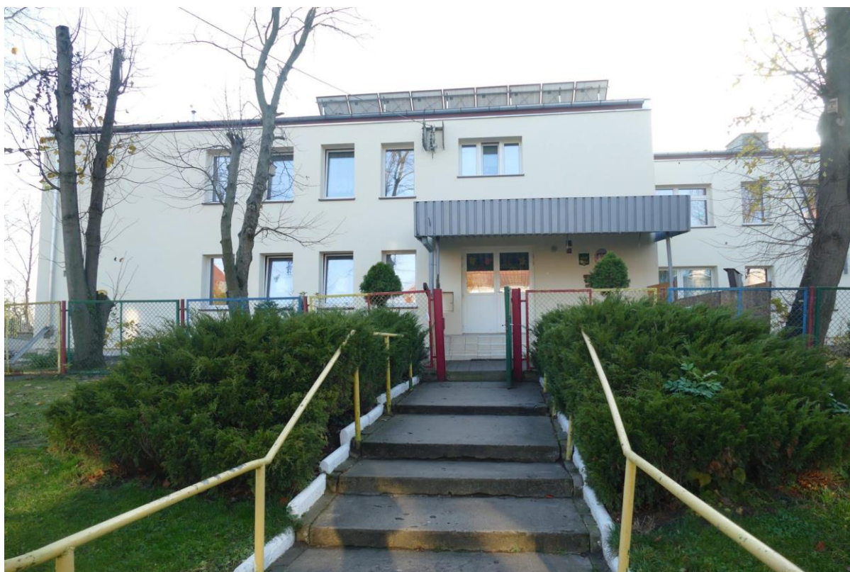
Foto: Przedszkole w Korszach po termomodernizacji.
