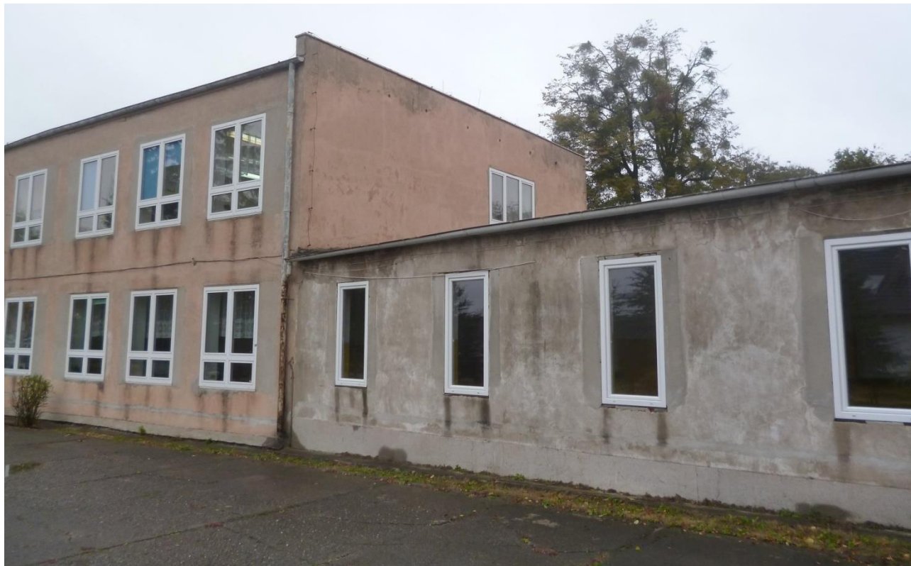
Foto: Szkoła Podstawowa w Korszach przed termomodernizacją.
