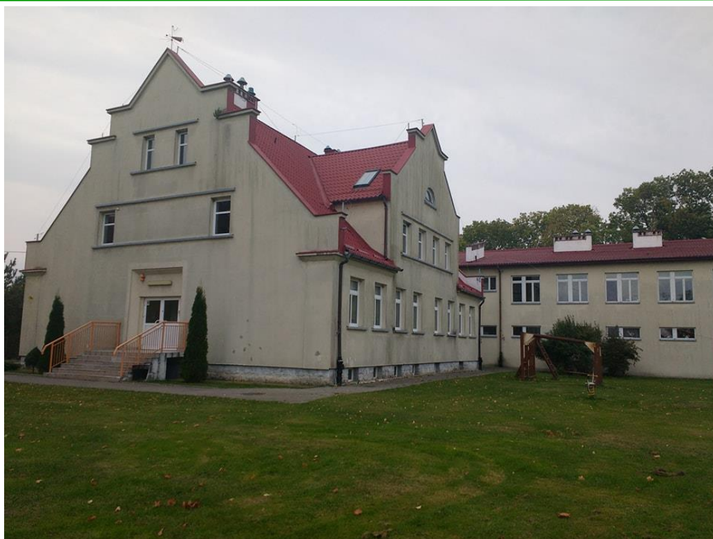
Foto: Szkoła Podstawowa w Łankiejmach przed termomodernizacją.
