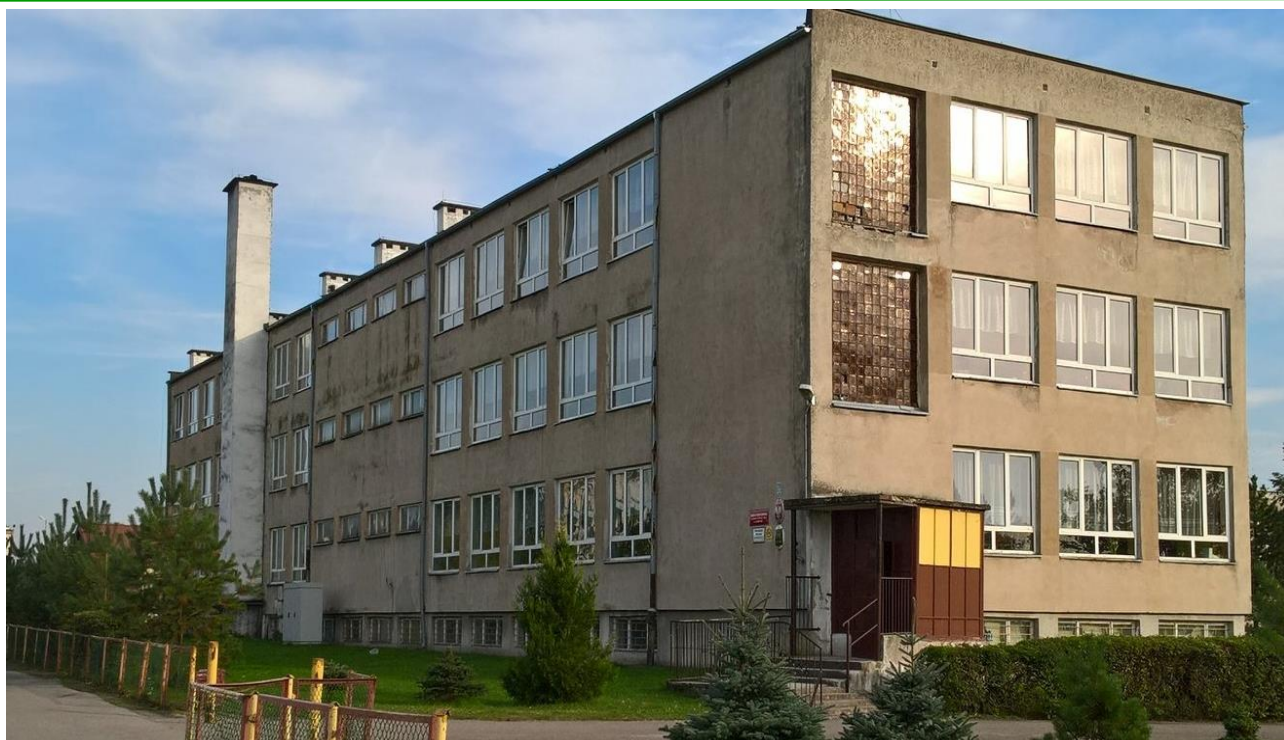
Foto: Szkoła Podstawowa w Garbnie przed termomodernizacją.
